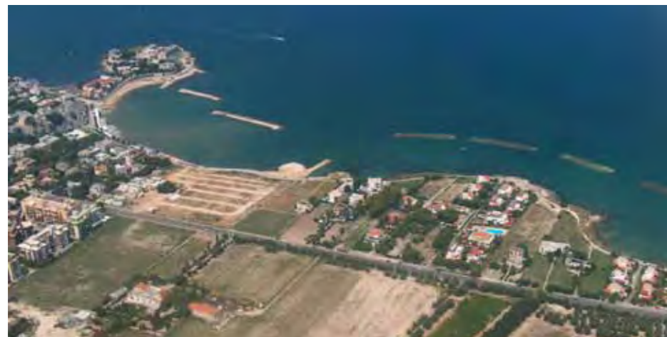
Capo Colonna ad est di Trani, sistema di barriere frangiflutti costruito per contrastare il fenomeno di erosione costiera
