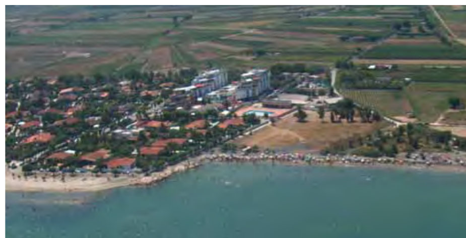
Opere di difesa radenti lungo il tratto costiero prossimo al porto di Margherita di Savoia.
