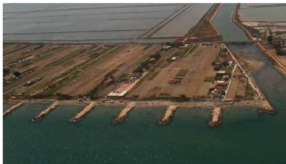
Difese trasversali realizzate lungo il tratto costiero antistante le Saline di Margherita di Savoia in corrispondenza di Foce Carmosina, tra la foce del T. Carapelle e l'abitato di Margherita di Savoia
