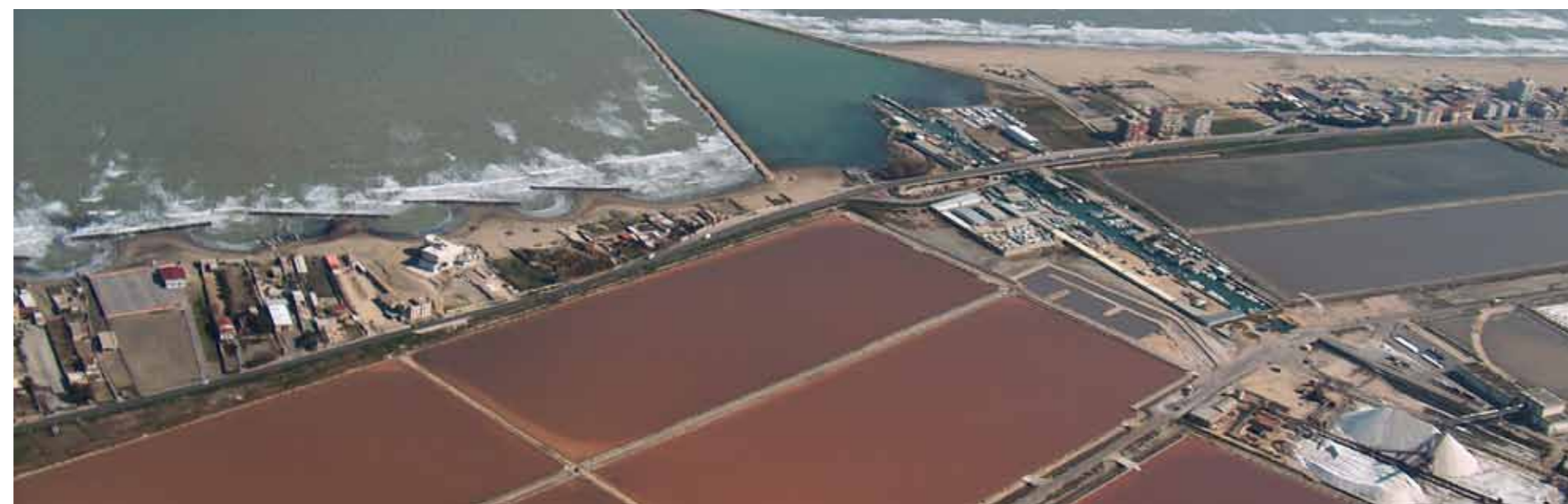
Porto di Margherita di Savoia, l'arenile formatosi a ridosso del molo di levante in seguito all'accumulo dei sedimenti trasportati verso nord dalle correnti litoranee
