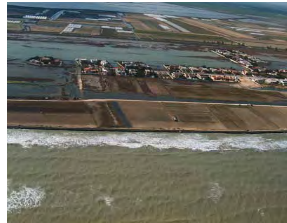
Manfredonia, la piattaforma turistica-ricettiva-residenziale di Ippocampo edificata a ridosso della foce del torrente Carapelle
