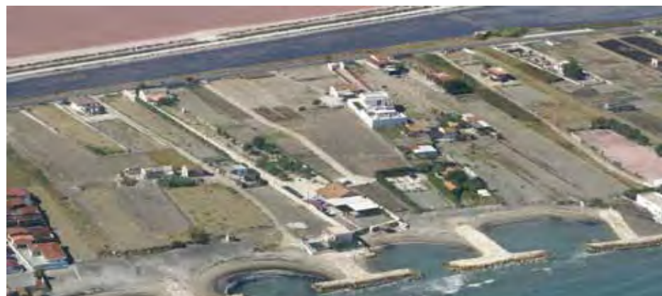
La serie di opere di difesa radenti e trasversali che armano la costa prossima al porto di Margherita di Savoia
