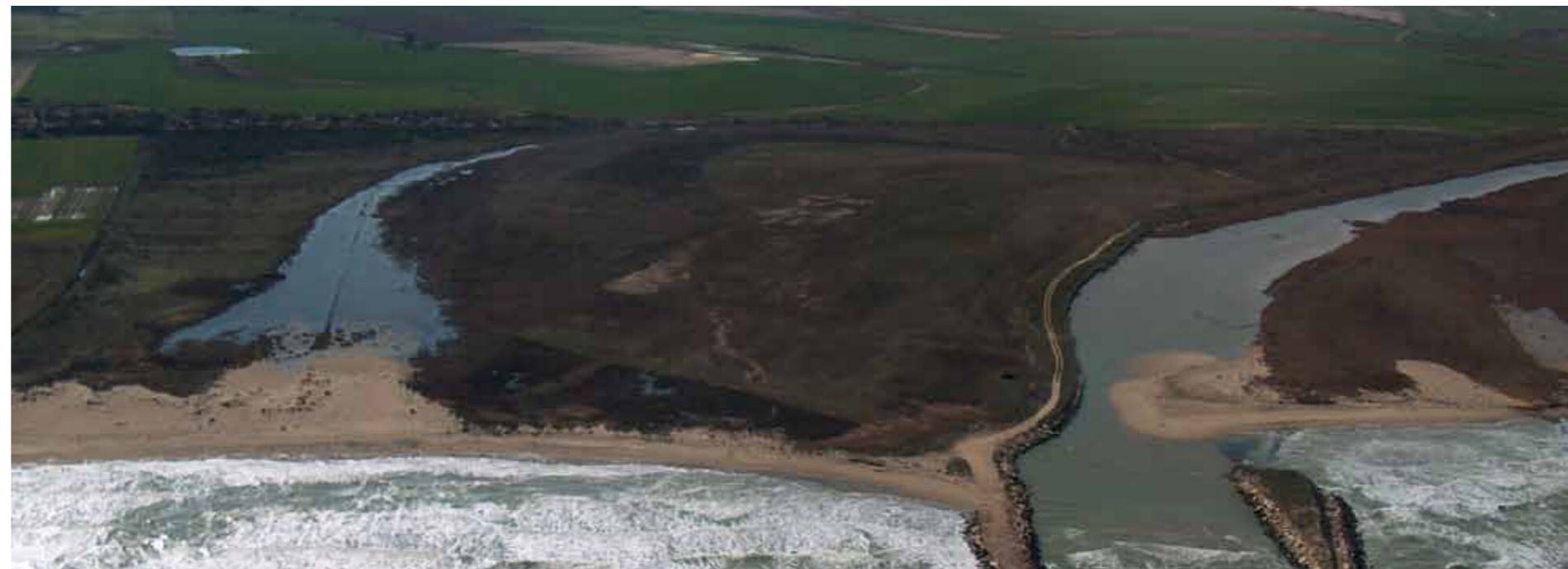
Serracapriola, le dinamiche fluviali naturali hanno danneggiato l'armatura della foce del Fortore, causando il distacco del braccio di ponente
