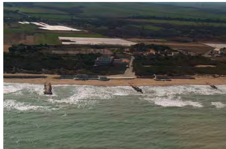
Chieuti, opere di difesa trasversali in località Torre Fantine
