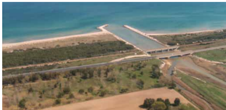
La foce armata del fiume Saccione tagliata dal corridoio infrastrutturale della ferrovia e dell'Adriatica
