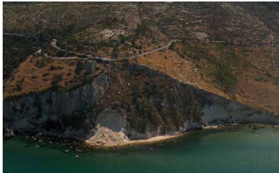
Monte Pucci al confine tra Vico del Gargano e Peschici, con parete rocciosa soggetta a distacco di roccia e crollo di blocchi
