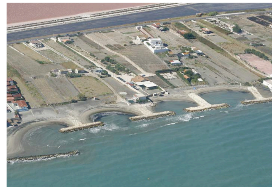
La serie di opere di difesa radenti e trasversali che armano la costa, Margherita di Savoia
