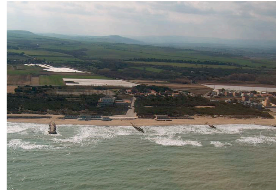
Chieuti, opere di difesa trasversali in località Torre Fantine
