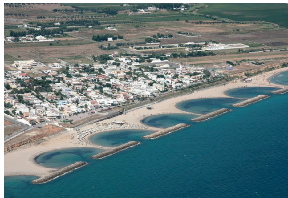
San Pietro Vernotico, opere di difesa longitudinale costruite per contrastare i fenomeni di erosione costiera in atto
