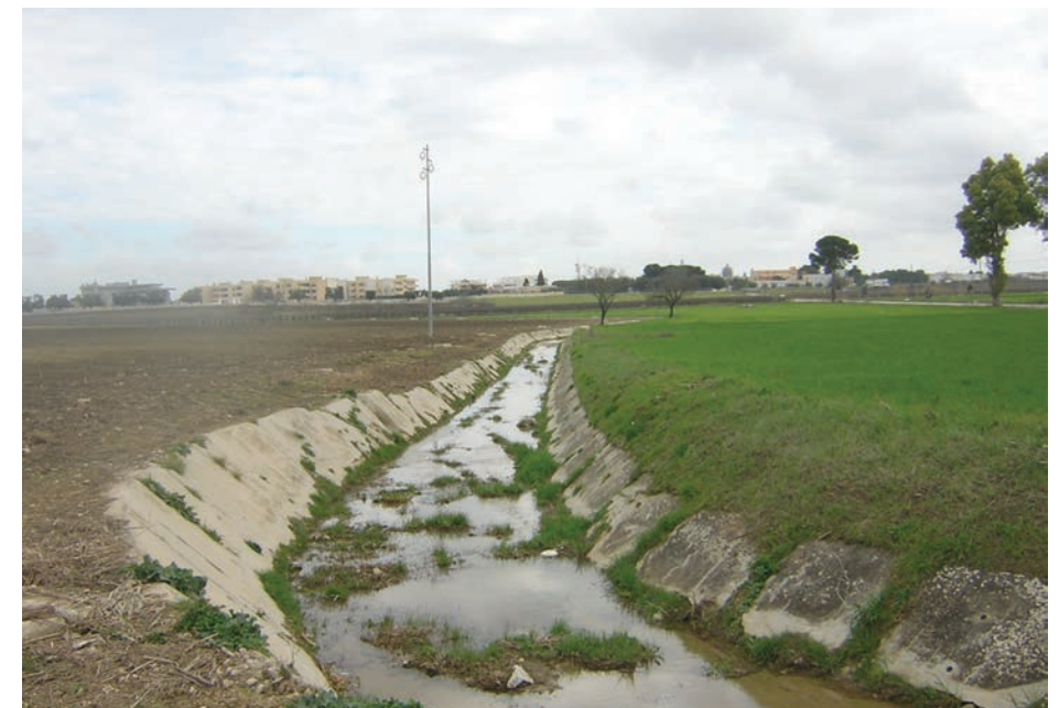
Impermeabilizzazione dell'alveo - Francavilla Fontana
