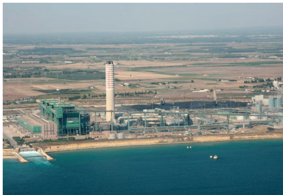
Centrale ENEL di Cerano, la falesia su cui poggia l'impianto presenta forti segni di degrado ed è scavata al piede
