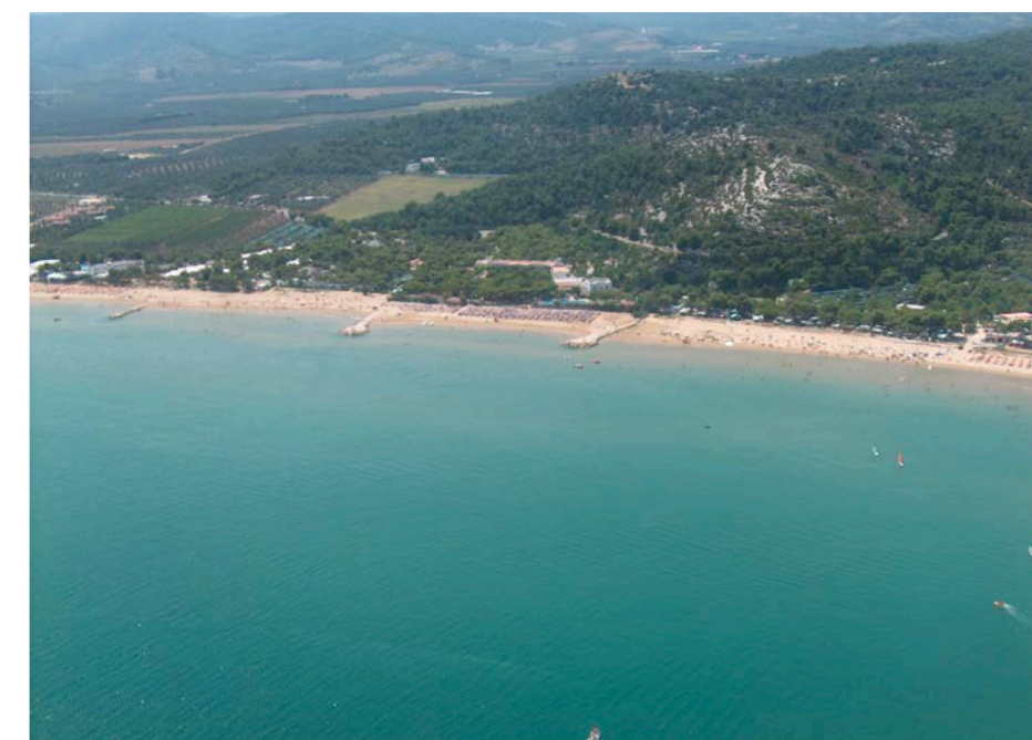
Spiaggia di Scialmarino (Vieste), opere di difesa trasversali a protezione dai fenomeni di erosione
